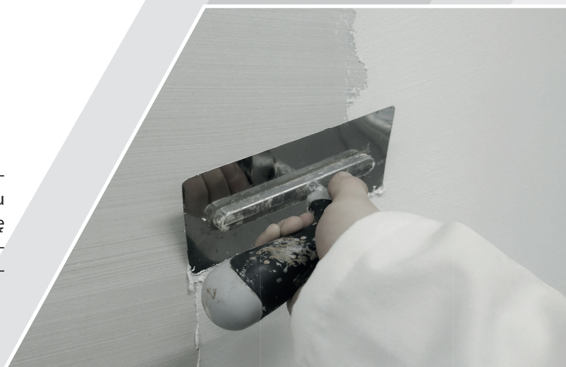
Nakładanie pierwszej warstwy Mitech Artbeton
