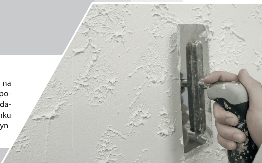
Nakładanie drugiej warstwy Mitech Artbeton
