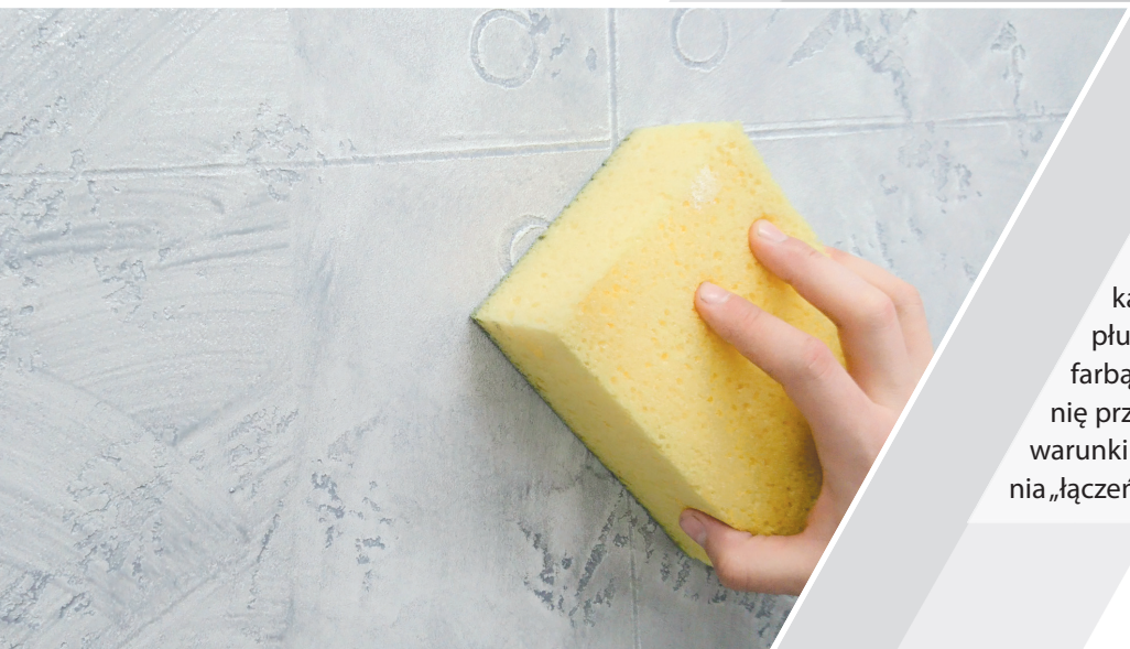
Przetrzeć gąbką ruchami kolistymi, nie pozostawiając śladów po gąbce
