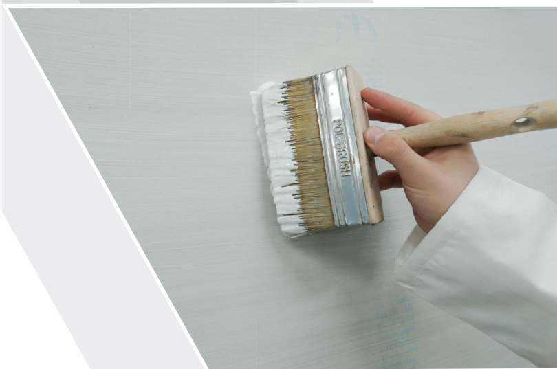
Gruntowanie podłoża
