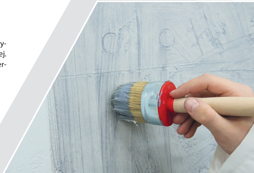
Nakładanie farby lazurującej na powierzchni masy dekoracyjnej
