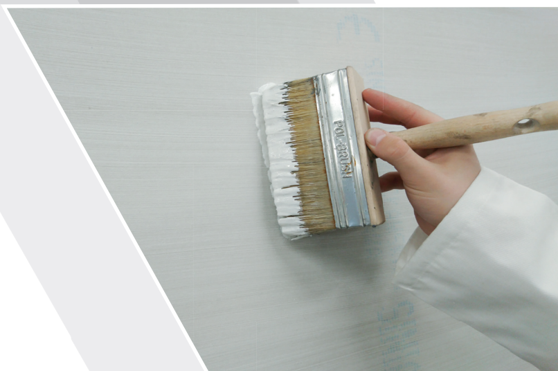
Gruntowanie podłoża
