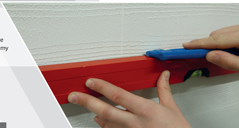
Wykonanie spoiny za pomocą zdzieraka do fug
