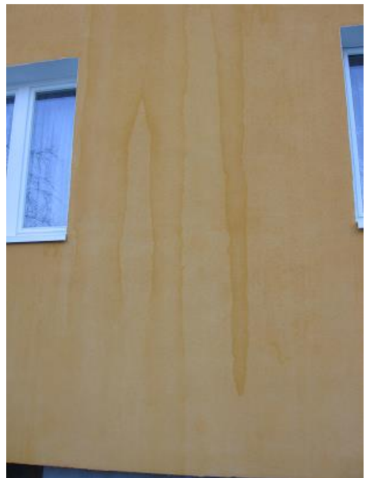
Zalanie tynku mineralnego przed malowaniem farbą elewacyjną, drastyczne pogorszenie wyglądu elewacji, widoczne zacieki
