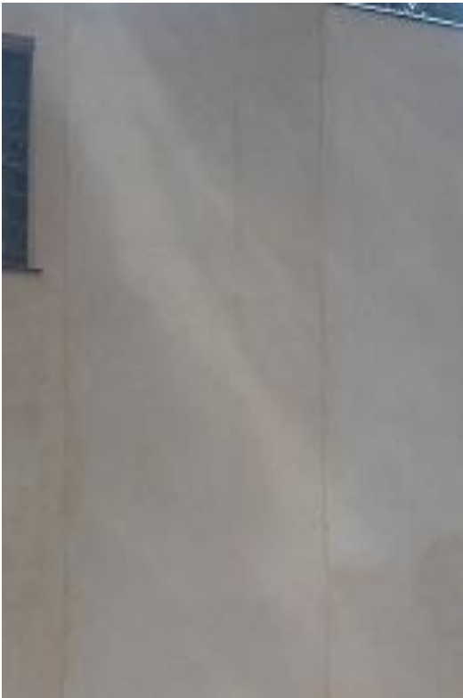
Aplikacja tynku w wysokich temperaturach, widoczne połączenia tynku
